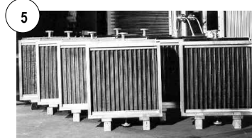
5 Damp/luftvarmeveksler-elementer, ribberørdførelse.
